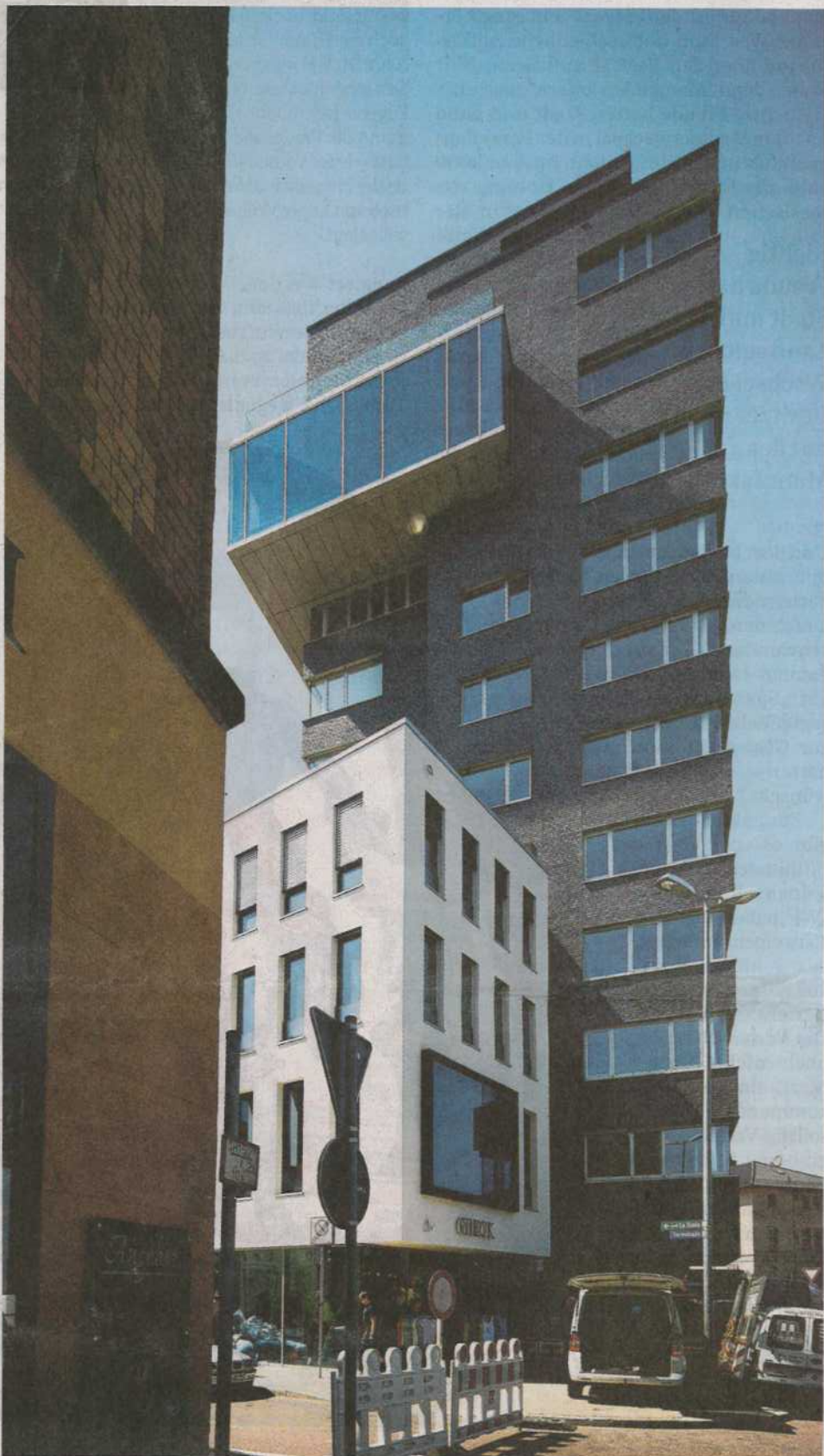
Braune Klinkersteine hüllen das 40 Meter hohe Gebäude ein.
